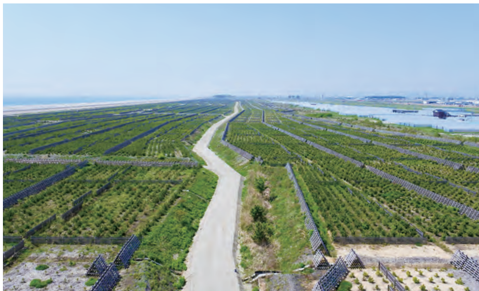
2014・15年植栽地全景。1年前よりクロマツが色濃くなった
